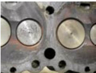
Sprickan syns tydligt mellan in-sugsventilen i vänster förbränningsrum och avgasventilen till höger i det andra förbränningsrummet.
