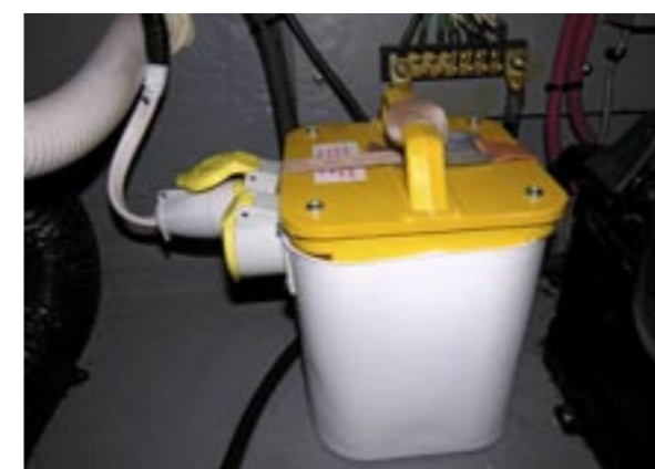
Omformaren från 220 V till 110 V.
