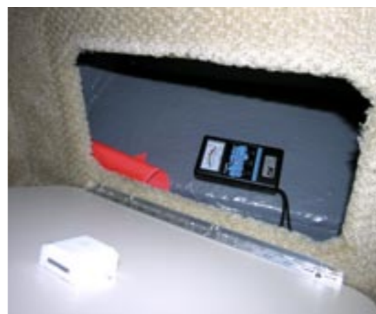
Men inte bara där. Skrovet är blött rakt igenom laminatet efter sju säsonger.
