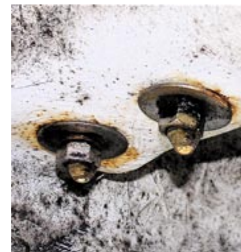
Däckets sandwichlaminat läcker ut vatten genom bultförbanden.
