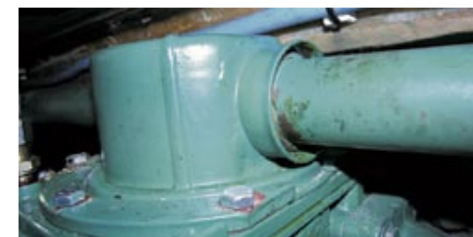
Styrbord motors söndersågade laddluftkylare och däcksbalken.
