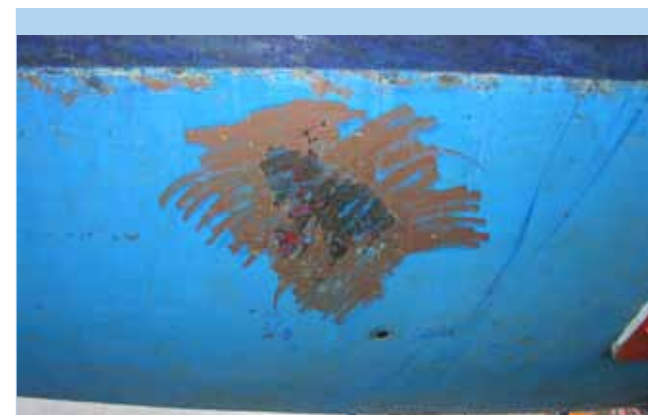
En svenskbyggd 97 år gammal segelbåt med många lager giftfärg som bevara fukten vintertid. Se nästa bild.
