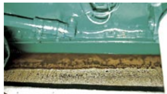
Pölen under motorn avslöjar vattenläckage i drevgenomföringen.
