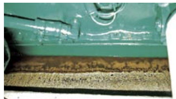
Pölen under motorn avslöjar vattenläckage i drevgenomföringen.
