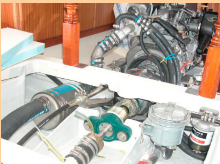
Drivfunktion och kringutrustning, från vänster i bild: Ljudisolationsvägg (med lock), avgasslang, vattensamlare, växelkabel med fästarm, backslag Technodrive TMC 60, trycklagerskott med långsgående förstärkningar, trycklager Aquadrive CVB05.10, Vetus vattenfilter samt Delphi 296 bränslefilter med vattenavskiljare.
